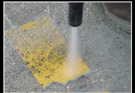
Przygotowanie betonowej powierzchni
